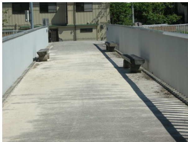
ゆけむり橋歩道に越水の痕跡
