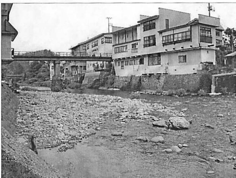
← 写真3 虹の橋上流 「固定堰」や「床止め工」によつて河床に砂礫がたまっている。
