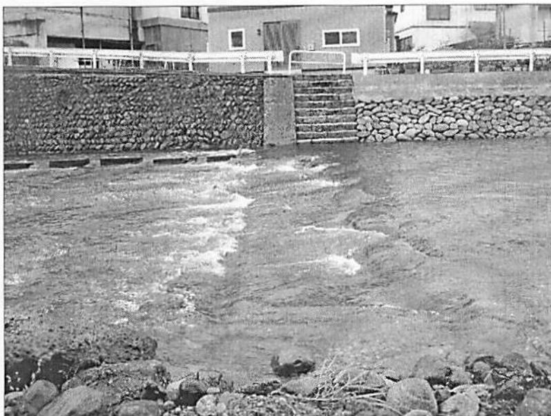
←写真6 虹の橋上流の護岸
