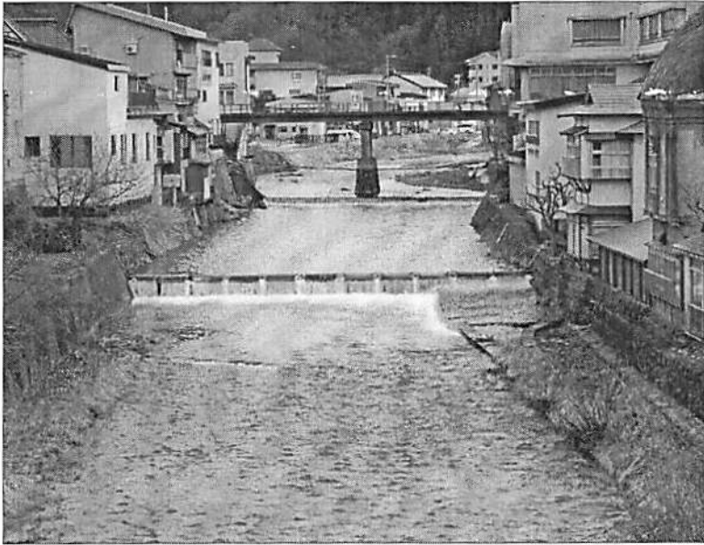
←写真1 赤倉橋から上流を望む 「固定堰」や「床止め工」によつて河床が高く保たれていることが分かる。
