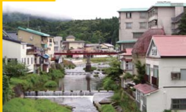
土砂堆積し、河道に迫り出す旅館も。
