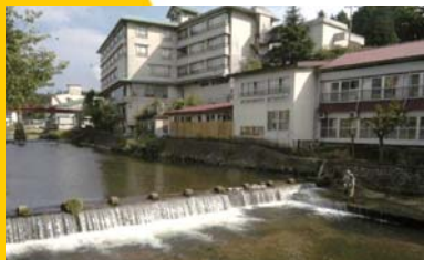
県がつくった堰が土砂堆積、水害の原因をつくりだしている。
