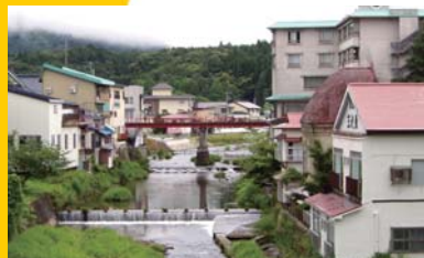
土砂堆積し、河道に迫り出す旅館も。
