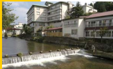
県がつくった堰が土砂堆積、水害の原因をつくりだしている。
