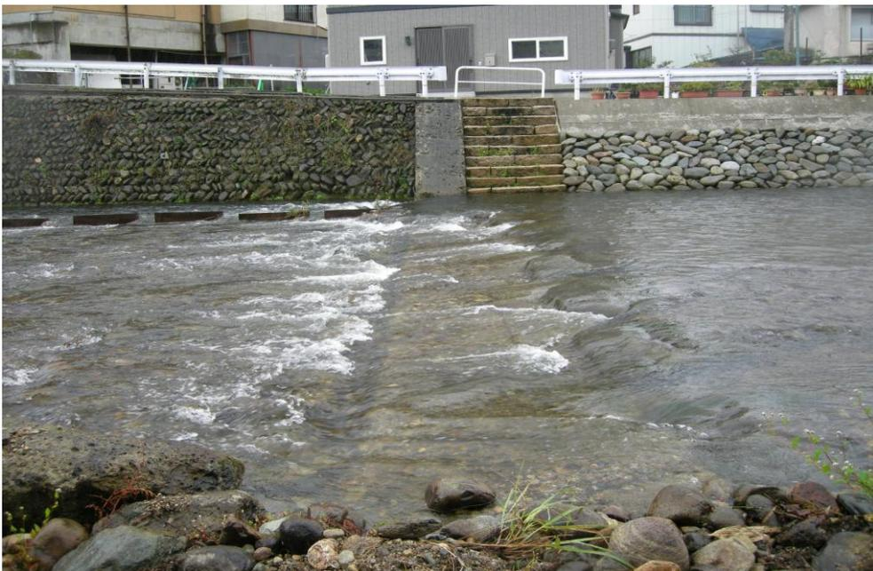
写真7 最上小国川・虹の橋の上流 55mにある落差工
