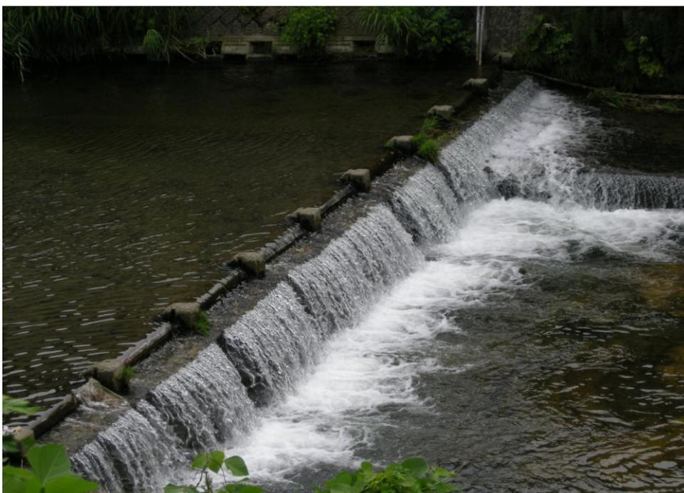
写真 5 同 堰に巾 0.15m の角材を設置した状態、
