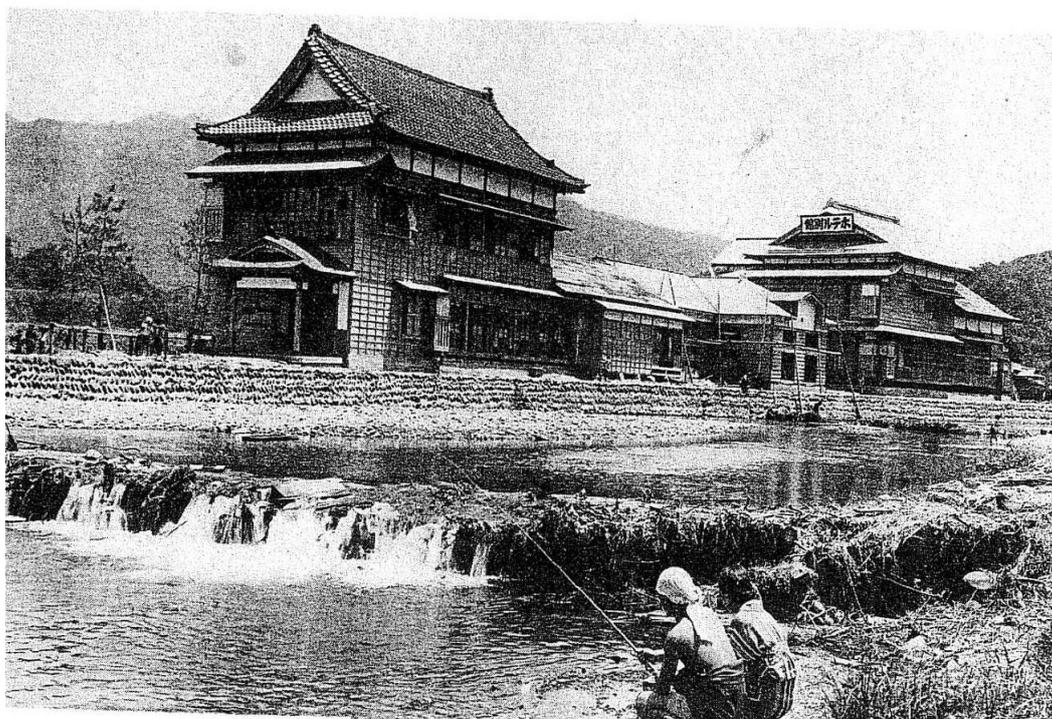
写真11 赤倉ホテル（昭和20年代、木枠組堰による堰上げの様子）
