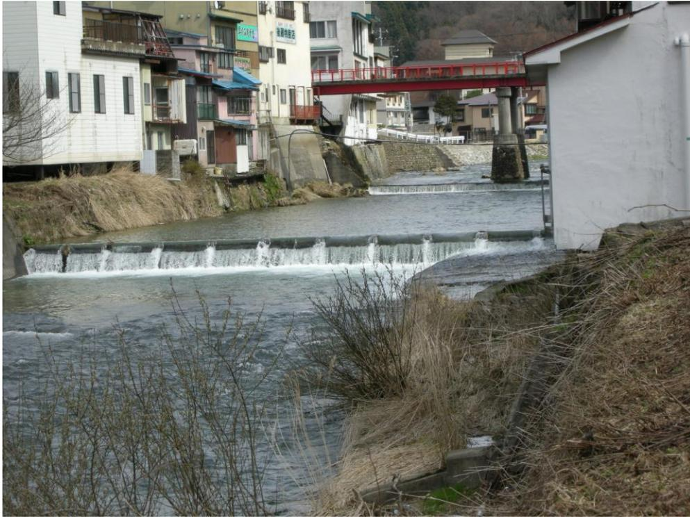
写真6 同 堰に巾0.3mの角材を設置した状態、
