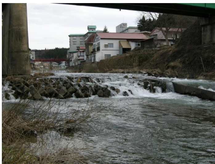
写真3：赤倉橋の橋脚 平成23年11月、原告撮影
