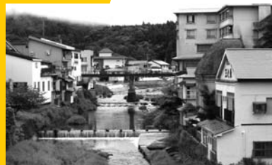
中央の堰が土砂堆積、水害の原因。
