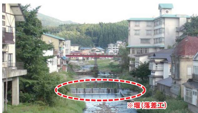
※堰(落差工)を取り外し、河道改修すると上図の様になります。
